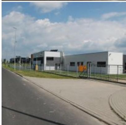
Zatorska Strefa Aktywności Gospodarczej FOTOGALERIA - czerwiec 2017
