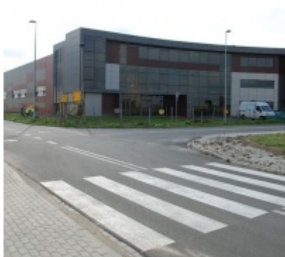
Zatorska Strefa Aktywności Gospodarczej - wrzesień 2013
