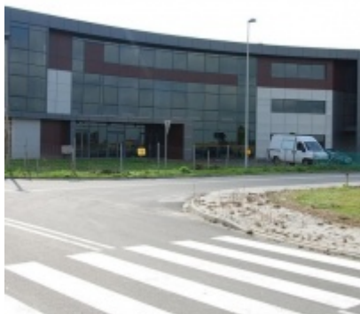
Zatorska Strefa Aktywności Gospodarczej - wrzesień 2013
