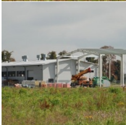
Zatorska Strefa Aktywności Gospodarczej - wrzesień 2013
