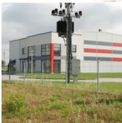
Zatorska Strefa Aktywności Gospodarczej - wrzesień 2013
