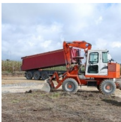
Zatorska Strefa Aktywności Gospodarczej - wrzesień 2013
