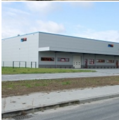
Zatorska Strefa Aktywności Gospodarczej - wrzesień 2013
