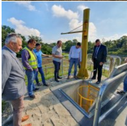
Budowa nowego ujęcia wody z rzeki Skawy.
