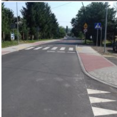
Droga powiatowa w Graboszycach już po modernizacji
