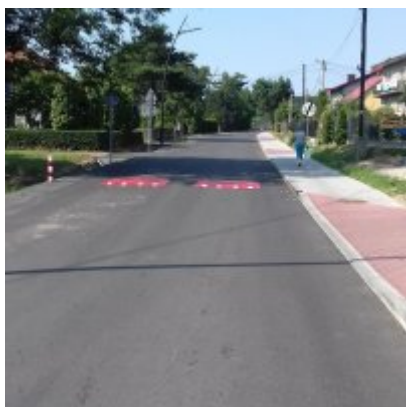
Droga powiatowa w Graboszytach już po modernizacji
